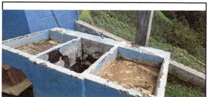
Foto 12: Se necesita sustituir de pila de cemento de dos lavaderos porque se encuentra en mal estado.
